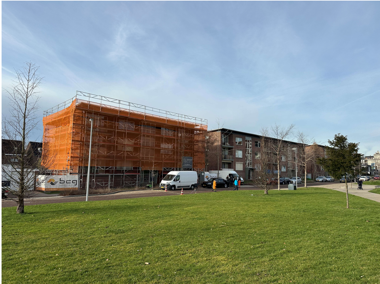
Figure 40: The Pastoorschleidenstraat building, Hoensbroek (Heerlen) (© B. Andaloro).
